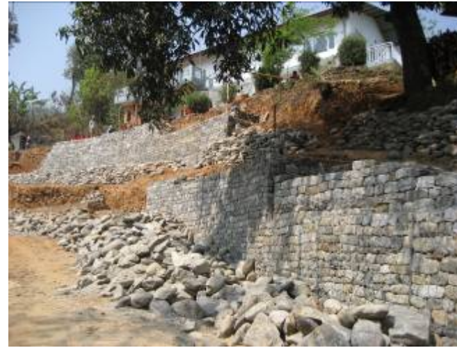
Sanierung des Zugangsweges zur Station
